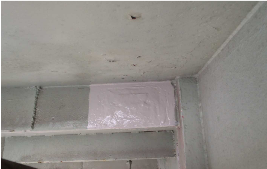
裏面にもトップコートを塗布する
