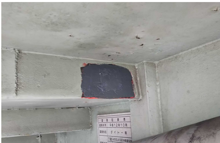
ラスタッフ(E)1110を塗布後メッシュを 貼り押さえる。 その上にラスタッフ(E)1110を塗布する。
