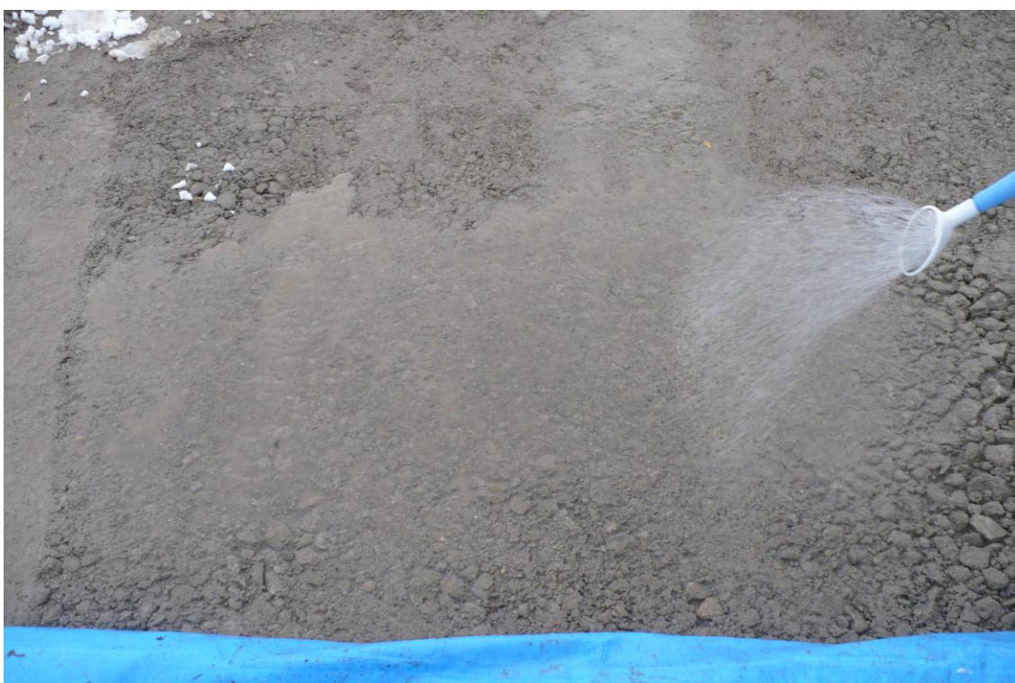
RC40 未処理土 散水の水が流れる
