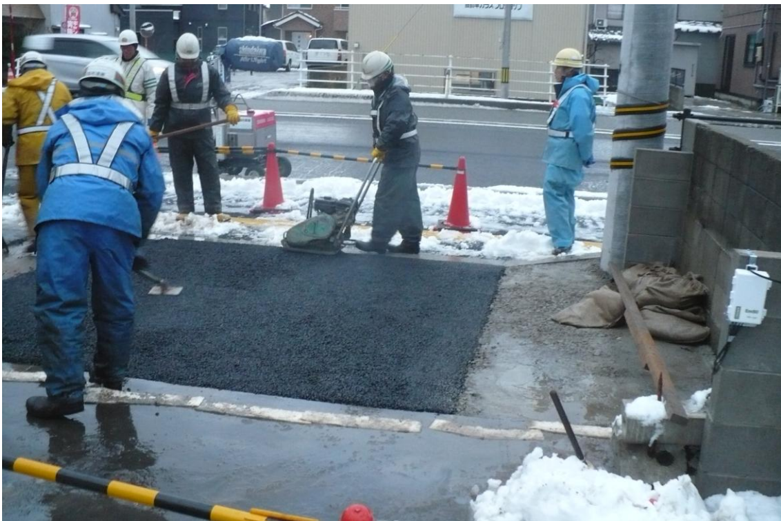
透水性舗装の施工
