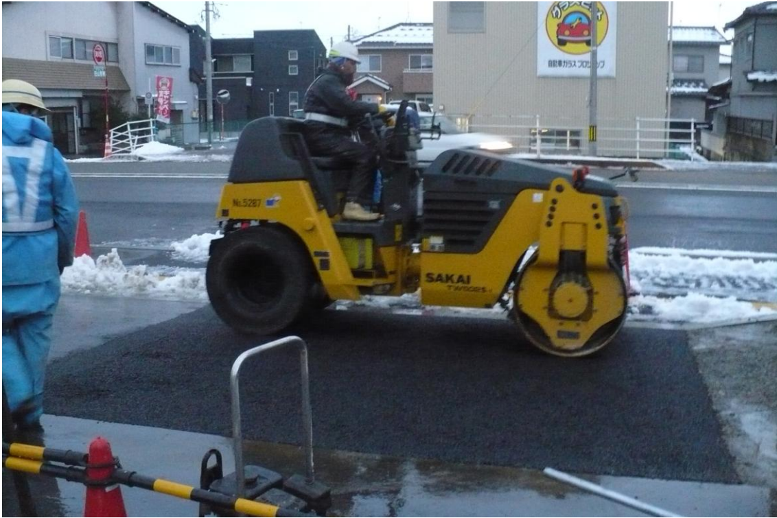
ローラで転圧
