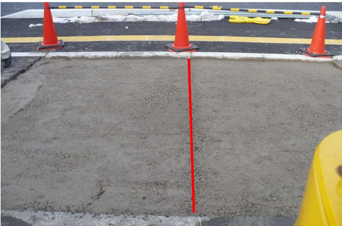
完成 右が ATTAC 路盤工法 左が RC-40 未処理
