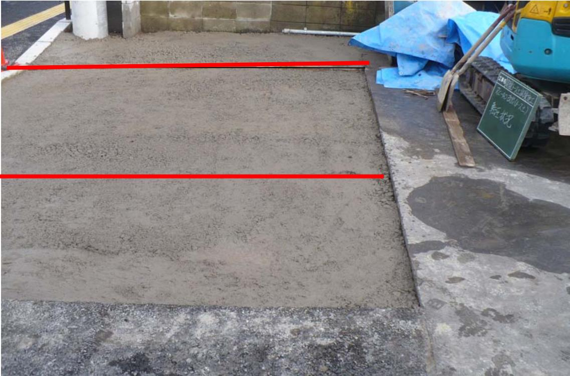
完成 一番上が ATTAC 路盤露出 中間が ATTAC 路盤 下が RC-40 未処理
