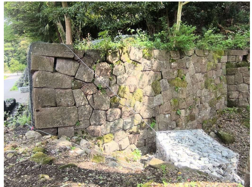
数寄屋敷西堀縁石垣 安全対策 STKネット大目合Φ3.0 R7.3
