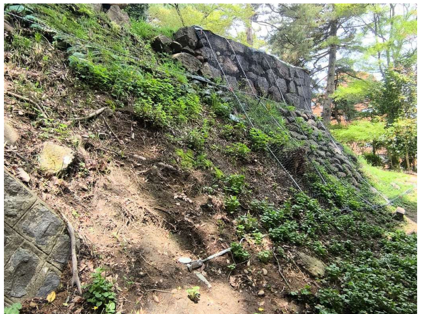
尾坂門北東石垣 安全対策 STKネット大目合Φ3.0 R7.3
