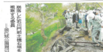
崩落した石川門前土樋を修復する様子
