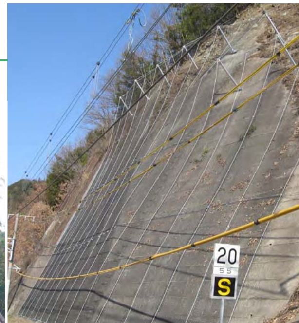
〈広島県〉 J R 呉線安浦安登間他落石対策 (JR 西日本 / 広島土木技術センター)
