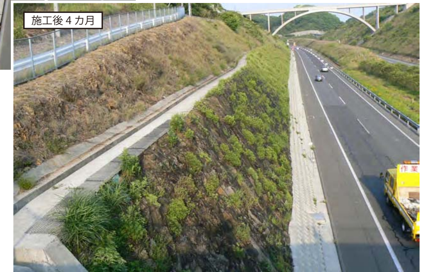
〈兵庫県〉 平成 19 年度神戸管内のり面防災工事 (本州四国連絡高速道路株)
