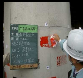
リモネンや ラッカーシンナーで 拭き取り除去。
